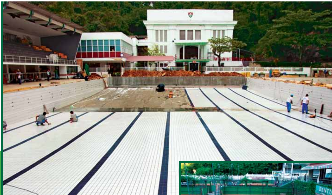
As obras da piscina e das quadras de tênis
